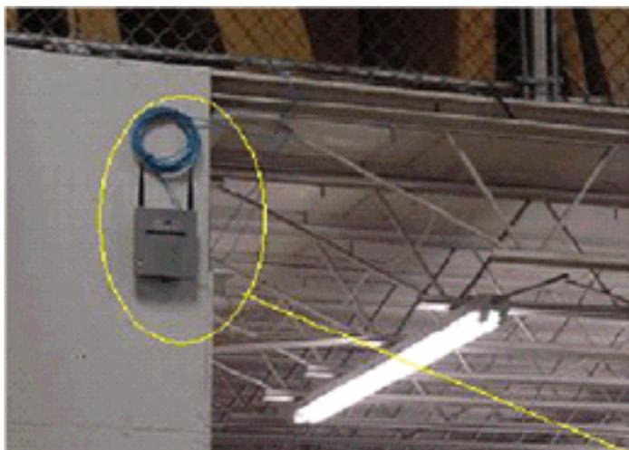
La figura 20 muestra la propagación de la señal causada por la pared en la que se monta el punto de acceso.
